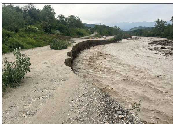
Рис. 4. Полотно объездной грунтовой автодороги, размытое паводковыми водами реки Нальчик [Fig. 4. Bypass dirt road bed eroded by flood waters of the Nalchik River]
