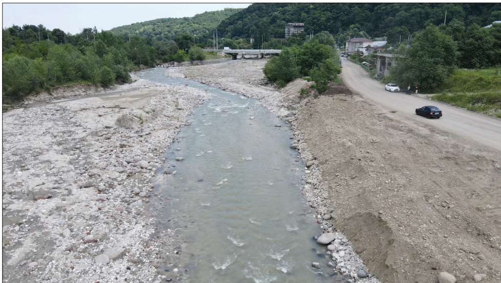
Рис. 6. Отсыпная грунтовая дамба на участке размыва автодороги паводком в 2023 году [Fig. 6. Backfill dirt dam at the section of the road erosion by flood in 2023]
