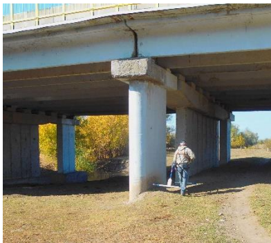
Рис. 6. Результаты георадиолокационного обследования промежуточной опоры моста на автодороге Р-228 в Саратовской обл. [Fig. 6. Results of geo-radar inspection of the intermediate bridge support on the R-228 highway in the Saratov region.]
