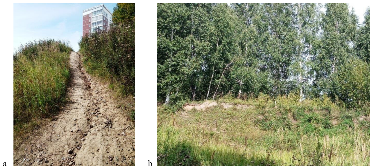
Рис. 2. Оползневой склон в мкр. Солнечный: a – промоина на склоне, b – оползневой цирк. [Fig. 2. Landslide in the microdistrict Solnechnyi: a – washout, b – scar.]
