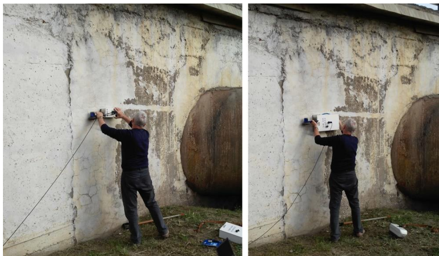
Рис. 3. Георадиолокационное обследование подпорной стенки переезда с антенными блоками 1.5 ГГц (слева) и 900 МГц (справа). [Fig. 3. Georadiolocation inspection of the retaining wall of the crossing using 1.5 GHz (left) and 900 MHz (right) antenna blocks.]
