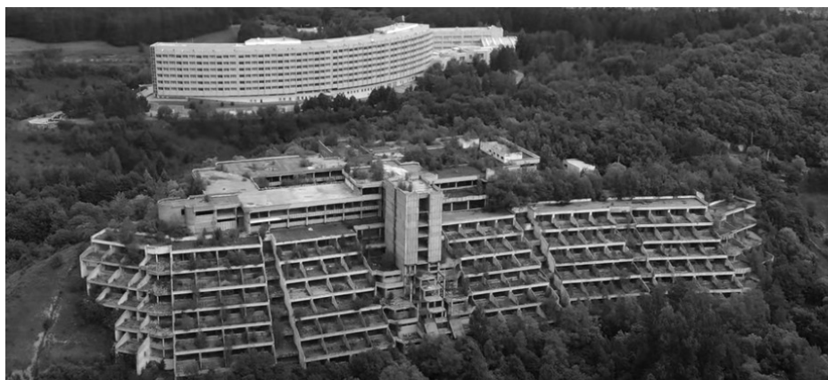
Рис. 2. Общий вид состояния санатория «Каскад», г. Кисловодск
